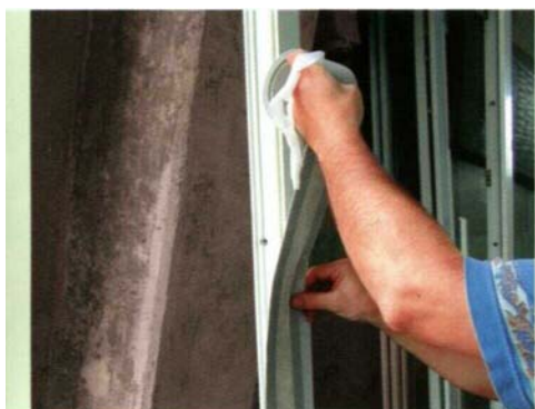
Приклеивание мембранной ленты illbruck "i3" Fensterfolie Aussen
