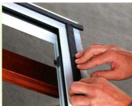
Приклеивание ПСУЛ illbruck "i3" illmod 600 (illmod 2D)
