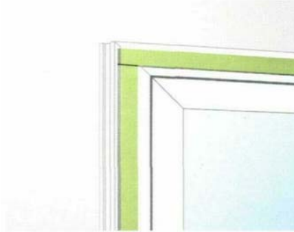
Рис. 1: Установка в углах оконных швов
